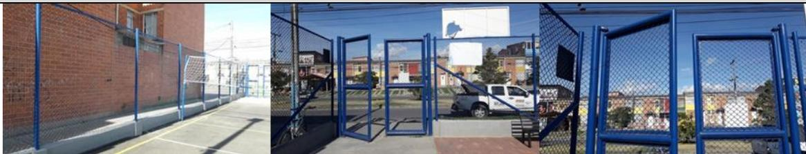
Pintura y reparación de cerramiento perimetral. Pintura en muro bajo cerramiento perimetral
