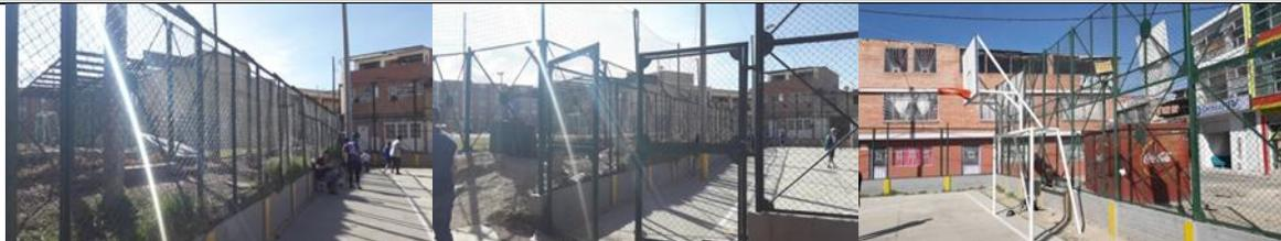
Arreglo y cambio total de malla de cerramiento perimetral y de la malla contra impacto. Se instaló el marco y la malla de la puerta. Pintura en muro bajo cerramiento perimetral
