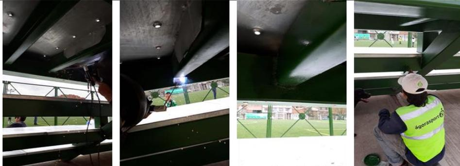
proceso de reparación y estado final - reparación de cordones de soldadura y pintura en algunos tramos de estructura de graderías
