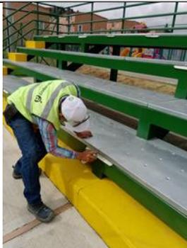
Limpieza del óxido presentado en las bandejas de las graderías y se aplicó pintura galvanizada en los tramos afectados
