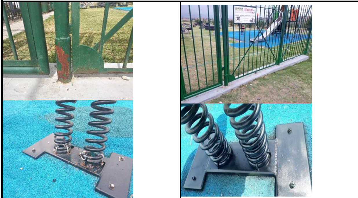
CTO. 509 de 2017. Vista de Antes y Después de efectuar reparaciones y mantenimientos por parte del contratista
