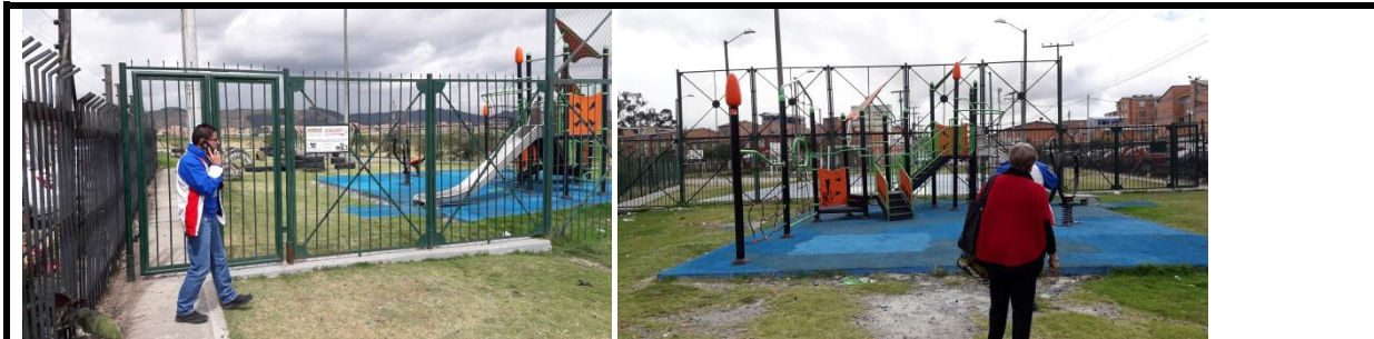
CTO. 509 de 2017. Vista general cerramiento nuevo h= 2.5m y modulo infantil.
